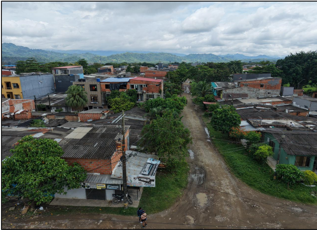
Imagen 1: condiciones iniciales encontradas
